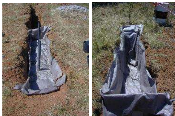
Figura 3 - Colocação do geotextil
