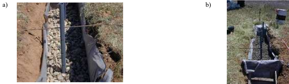
Figura 2 a) Trincheira (A) com enchimento de burgau; b) Trincheira (B) com enchimento de Leca
