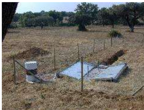
Figura 4 – Descarregador lateral de abastecimento do caudal em funcionamento
