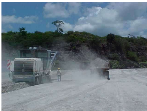
Figura 1: Máquina frezadora Extraíndo Calcário e Caminhão Transportando Material
