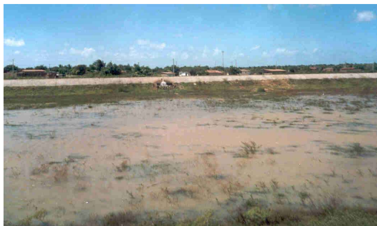
Figura 2. Vista da lagoa de decantação da ETE-DIN recebendo contribuição pluvial.
