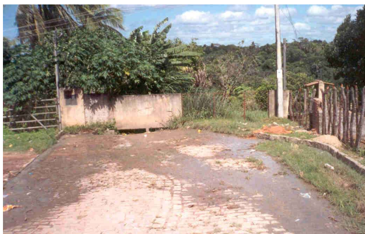
Figura 11. Vista do lançamento de esgotos domésticos (águas servidas) no Rio Golandim (detalhe para a boa cobertura vegetal ao fundo).
