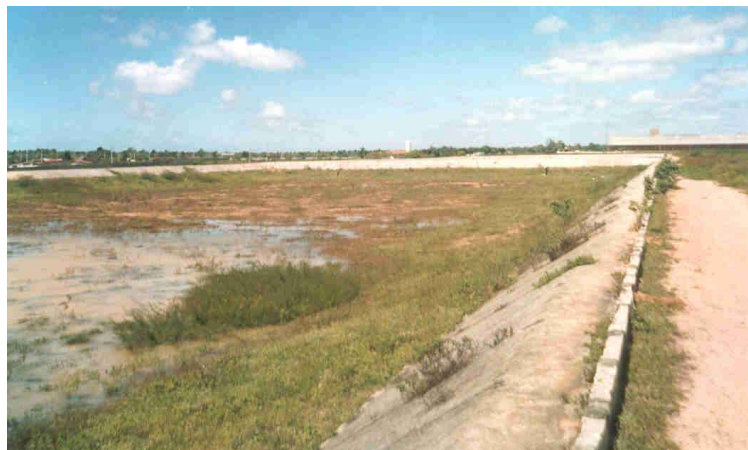
Figura 1. Vista da lagoa de decantação (desativada) da ETE-DIN.
