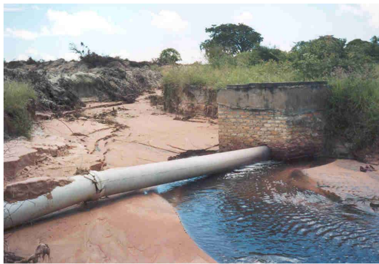
Figura 3. Lançamento de esgoto industrial no Rio Golandim proveniente da Estação de Elevação de Efluentes (emissário rompido devido ao processo de erosão no local).
