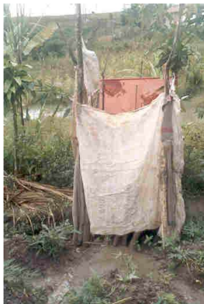
FIGURA 4: Privada negra com disposição final num riacho, situada na zona urbana.
