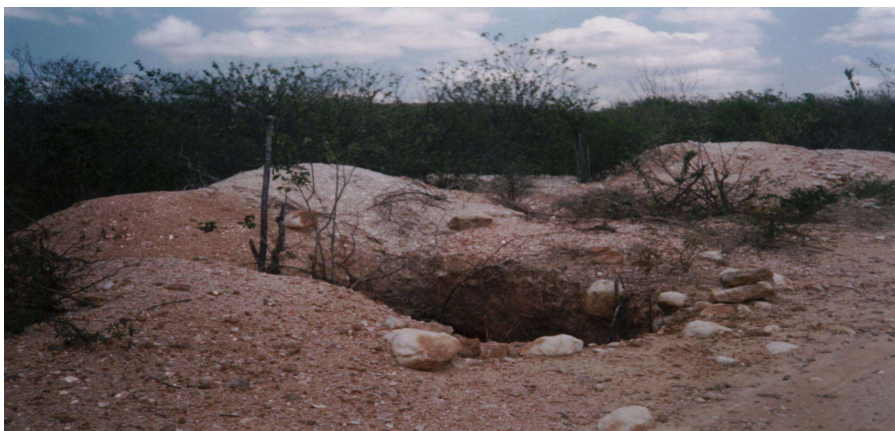
Figura 3. Visão geral de uma mina desativada. "Banqueta" abandonada.
