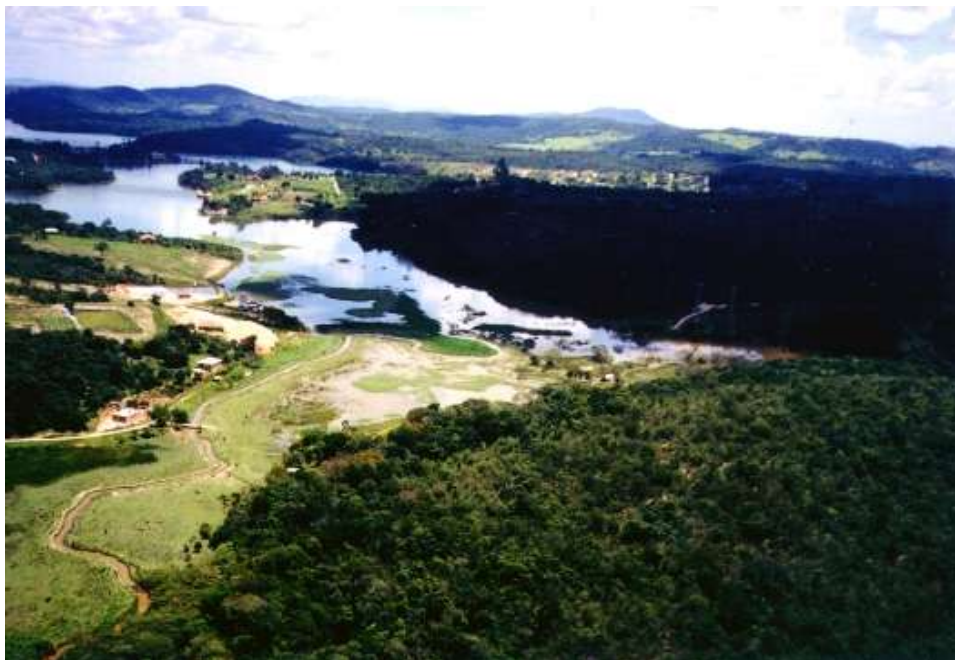
FIGURA 2 – Assoreamento já instalado na reunião das águas dos afluentes vindos da cabeceira do Município de Contagem. A represa já perdeu seu fundo para os esgotos que aí deságuam, depositando lixo e detritos continuamente.
